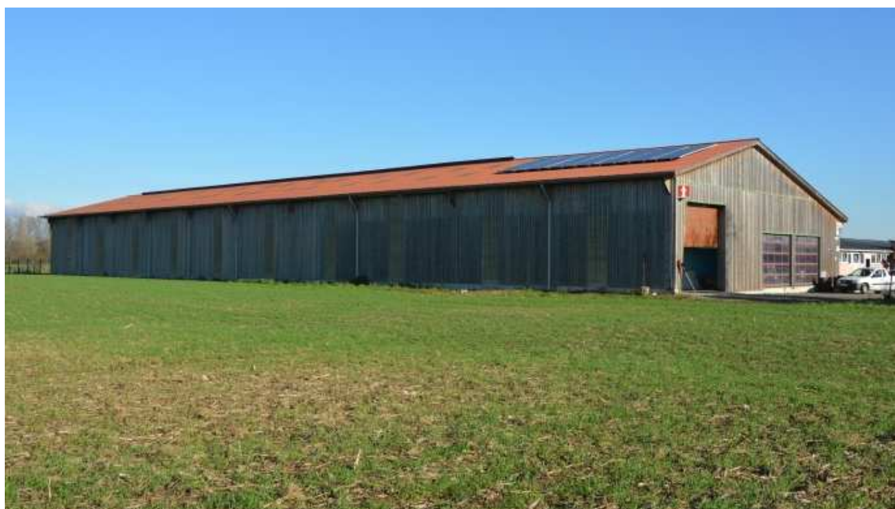
La toiture côté ouest permet de prolonger la production d'électricité en fin d'après-midi. Au total, la perte de rendement n'est que de 5 % par rapport à une exposition plein sud. (©Terre-net Média)
